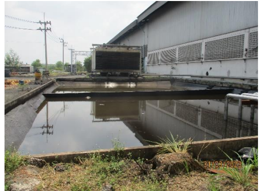
รูปที่ 8 บ่อดักตะกอนน้ำจากระบบหล่อเย็น
