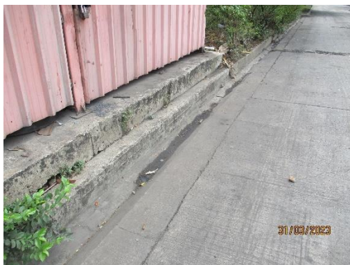
รูปที่ 21 รางรับน้ำรอบพื้นที่กักเก็บน้ำมัน
